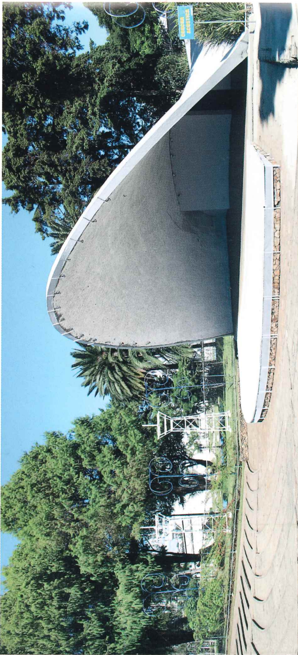
Concha acústica: Esta estructura, realizada por placas de concreto que forman un parabolóide hiperbólico de 20 metros de altura. Se construye en los años sesentas y su objetivo principal es la presentación de eventos musicales y artísticos.
